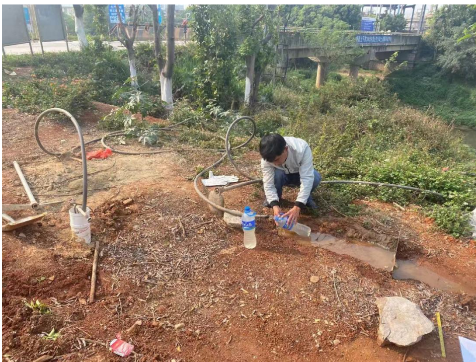
照片 5-1 现场抽水试验及水样采集照片
